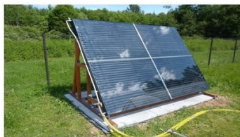
Сонячні колектори – перетворюють сонячну енергію на теплову
