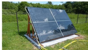
Сонячні колектори – перетворюють енергію електромагнітного випромінювання на теплову
