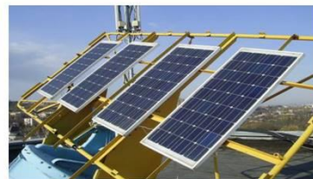
Сонячні фотоелементи – перетворюють енергію електромагнітного випромінювання на електричну
