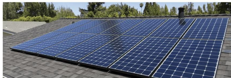
Сонячні фотоелементи перетворюють енергію електромагнітного випромінювання безпосередньо на електричну без будь-яких проміжних перетворень в інші види енергії
