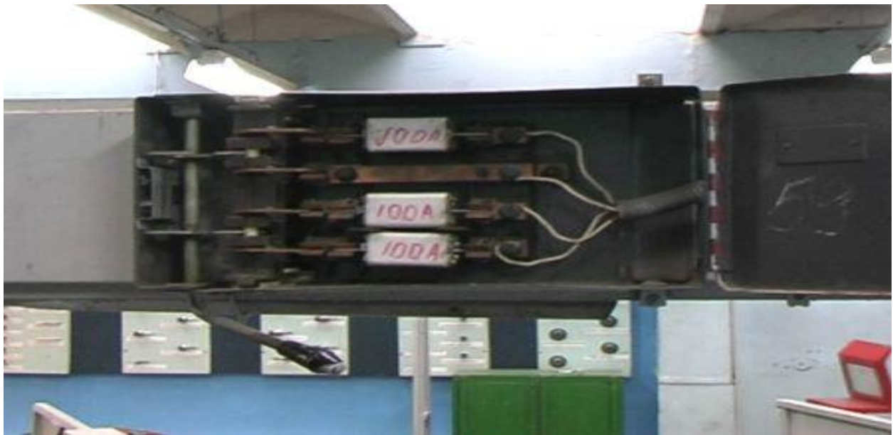
Рисунок 1.27 – Плавкі запобіжники в розподільному щиті
