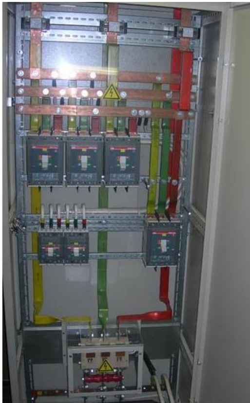
Рисунок 1.4 – Шини у вигляді мідних смуг в розподільному щиті
