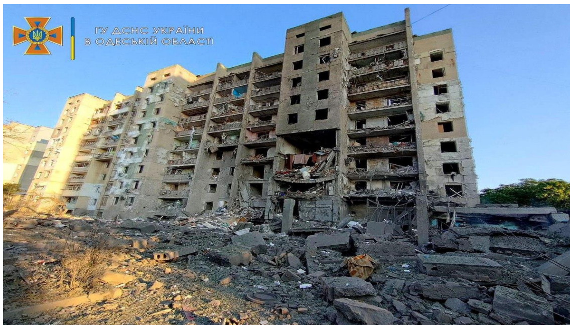
Рис. Ракетний обстріл, Сергіївка Одеська обл., 2023 р. Усі вікна і двері 1-7 етажів влетіли у кімнати з лудками. Людей на ліжках побило й засипало землею. Усі мешканці, хто рятувався у туалетних кімнатах, залишилися живими
