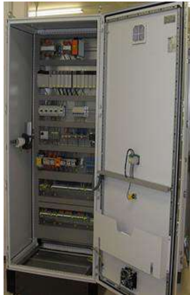
Захищена телекомунікаційна шафа з сейфовими дверима
