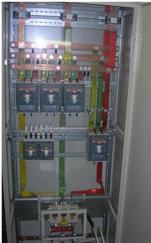
Рисунок 4 – Шини у вигляді мідних смуг у розподільному щиті
