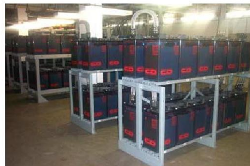
ДБЖ центру обробки даних (зліва) та його акумуляторна батарея (справа)
