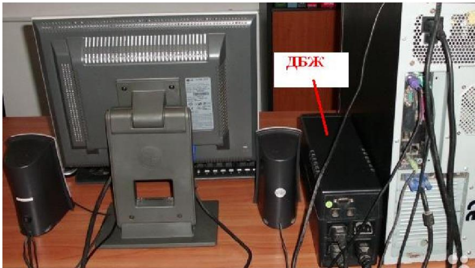
Живлення робочої станції (системного блока та монітора)
