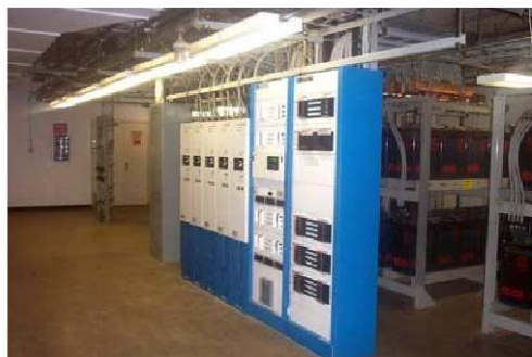
ДБЖ центру обробки даних (зліва) та його акумуляторна батарея (справа)
